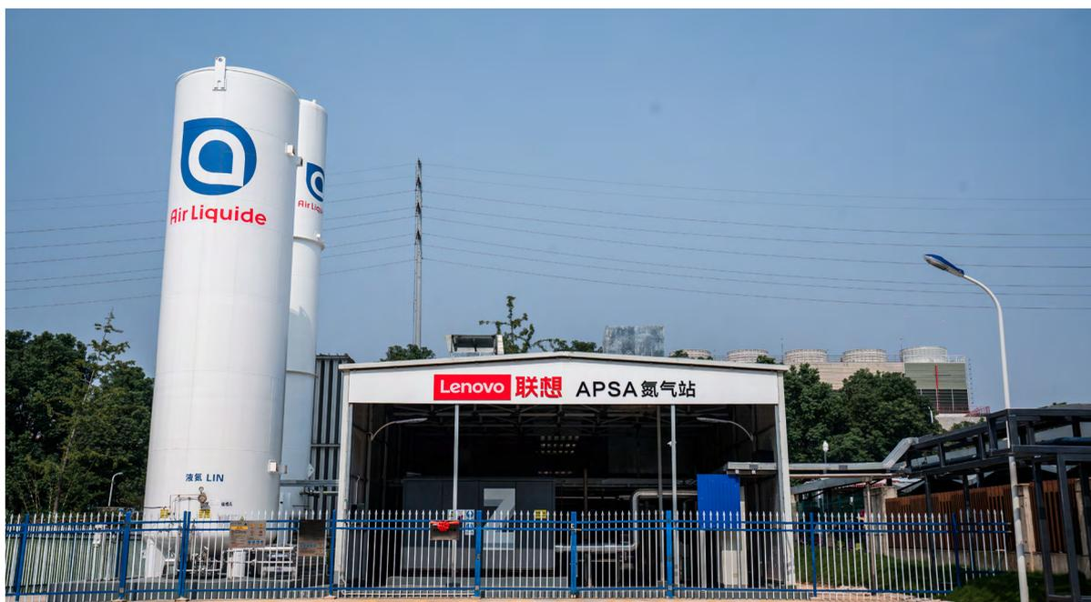
● 联想集团武汉产业基地 APSA 氮气站采用现场制气 + 后备液氮双系统供气模式，成为武汉基地动力供应的里程碑工程。
