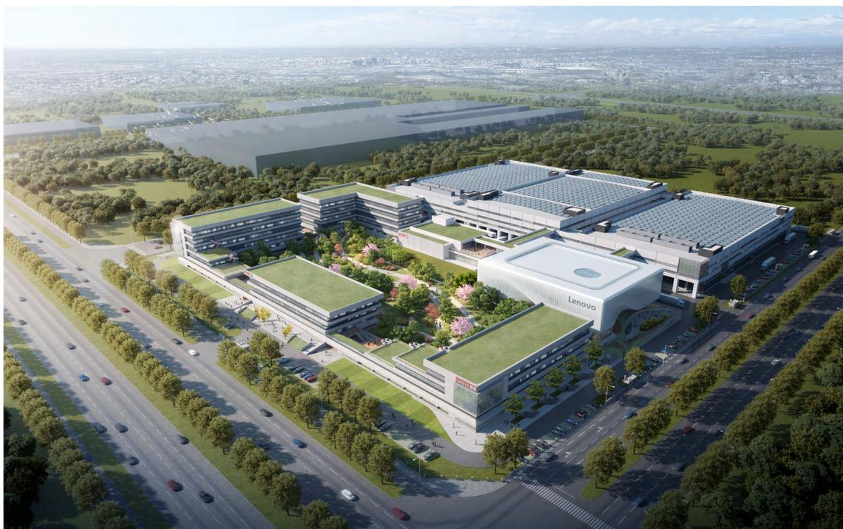
● 天津产业园三栋主体建筑之上将铺设2万平方米的分布式光伏发电板，年总发电量约263万度，用于园区展示中心全年用电需求。
